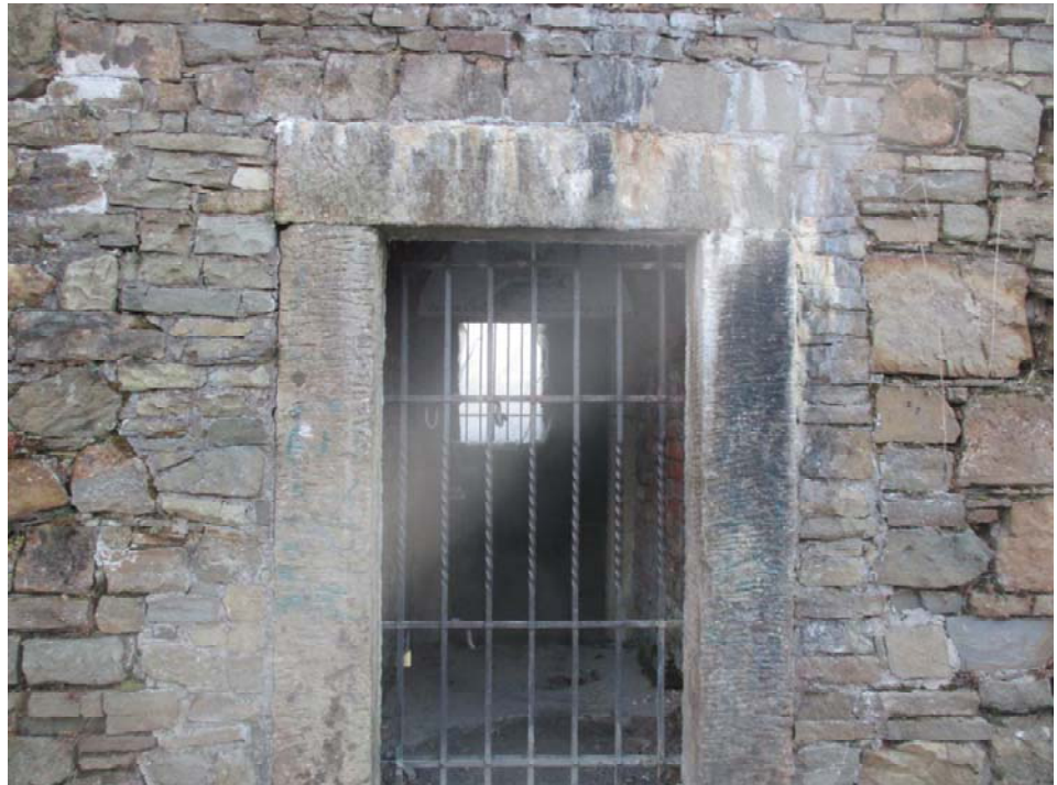
Baszta południowo wschodnia, stan zachowania, czytelne zabrudzenia kamienia, ubytki spoin, obecność soli
