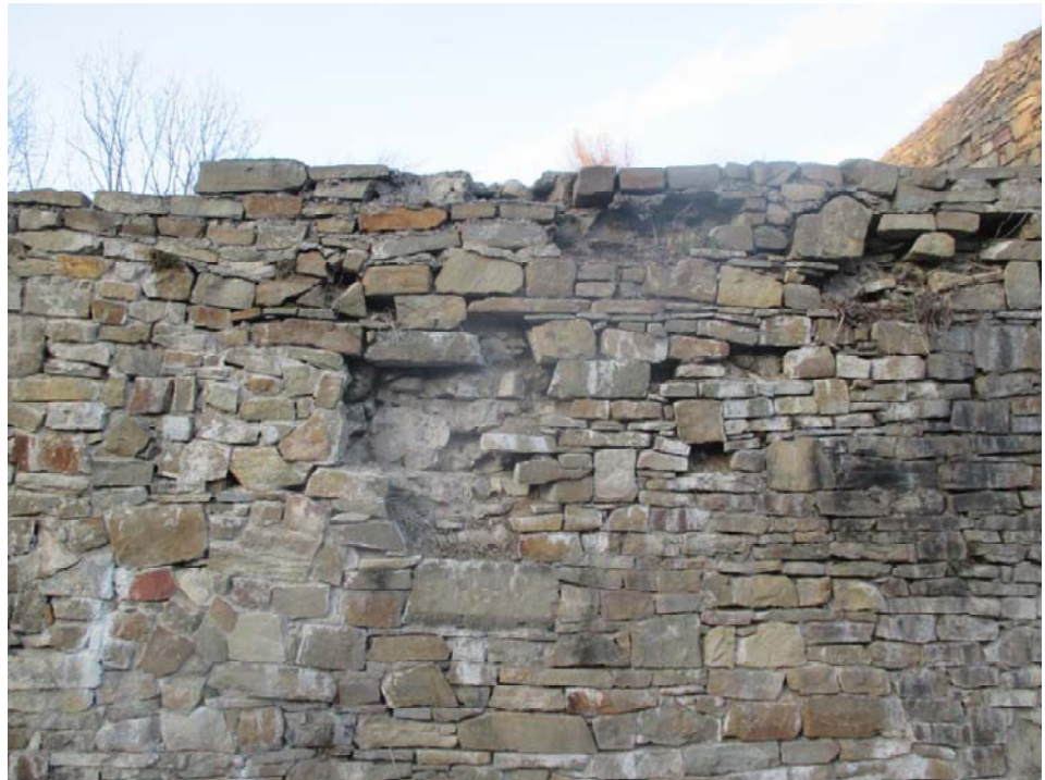
Mur obwodowy od południa, stan zachowania, ubytki wątku, obecność soli
