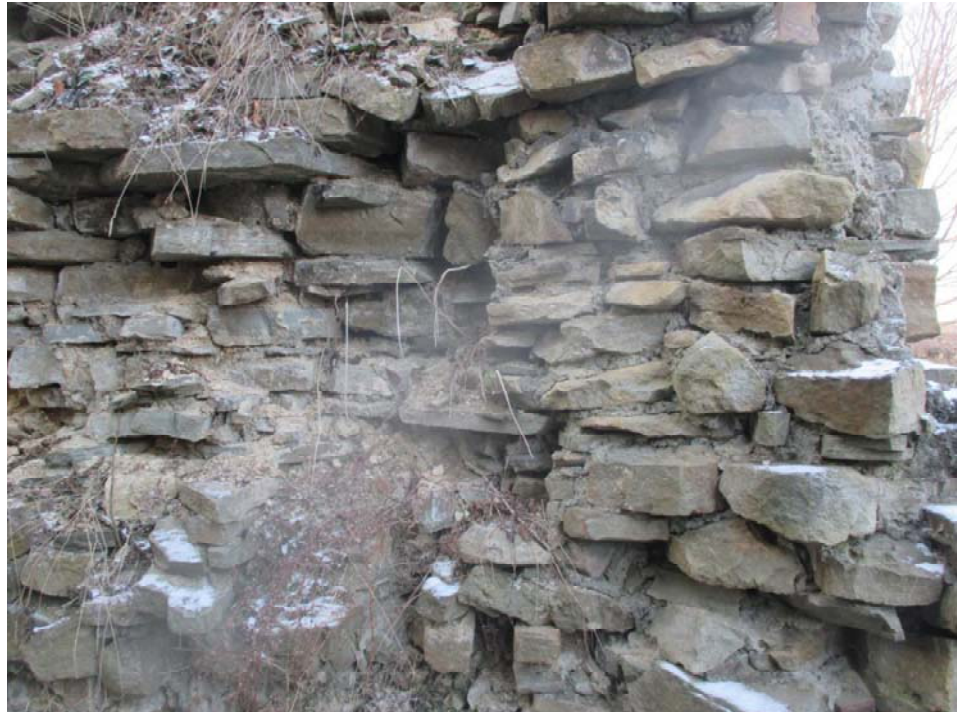
Baszta południowo zachodnia, ubytki muru
