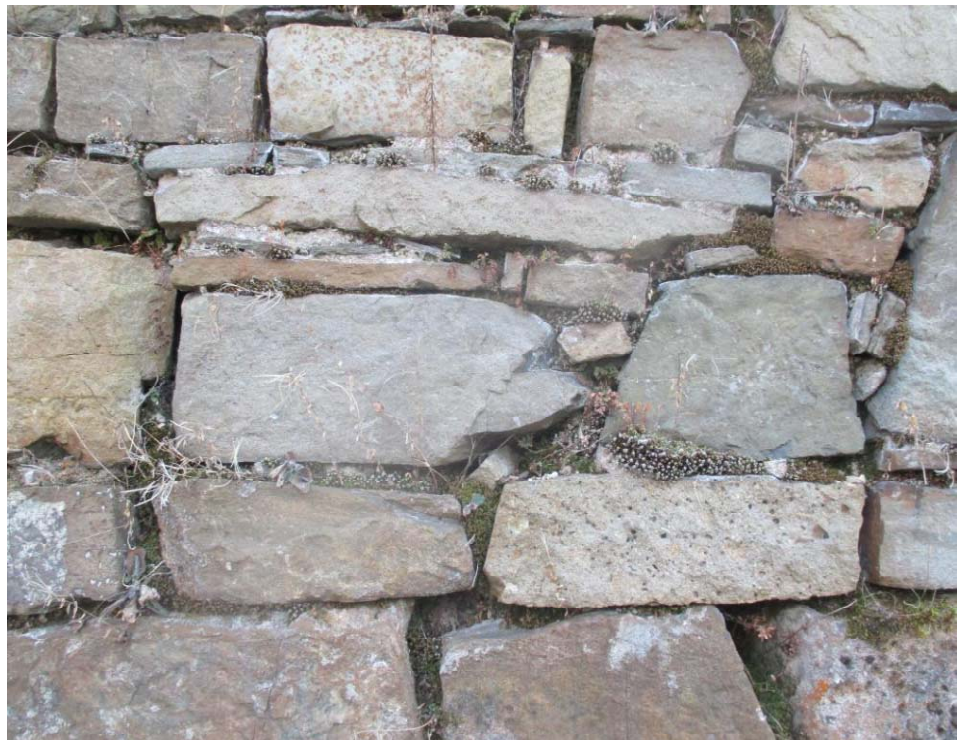
Twierdza Lanckorona, wątek kamienny muru, stan zachowania, roślinność w ubytkach spoin, obecność glonów
